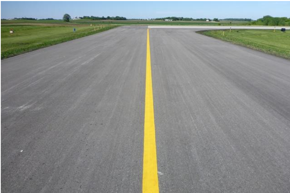
HCD PTA 001 (PCI = 100)
